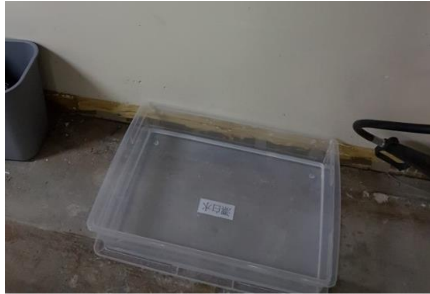
离场地盘前，将鞋浸入洗鞋盆，彻底清洁干净鞋底，防止带走鞋上灰尘
