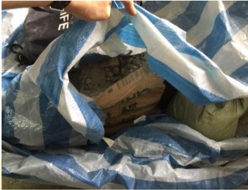
使用帆布覆盖已开包装的水泥
